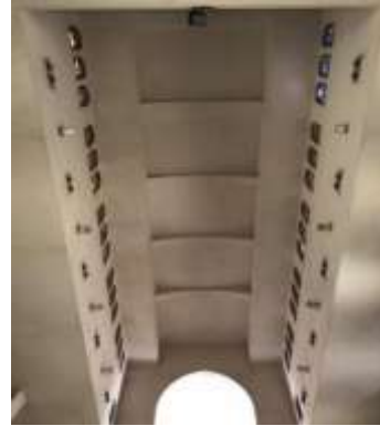
(شكل9) قبة صحن الكنيسة وتحميل السقف على عقود غير ظاهرة
