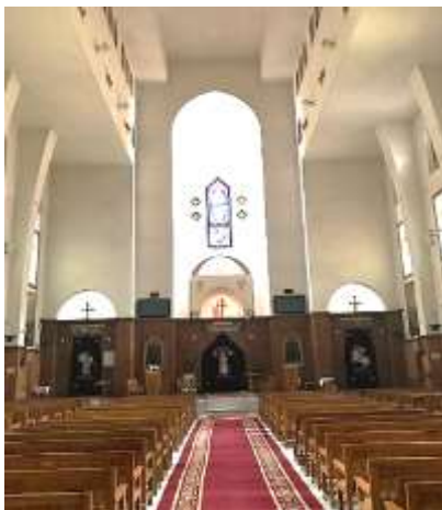
(شكل 8) صحن الكنيسة مع توظيف الإمكانات الإنشائية الحديثة للخرسانة المسلحة. مع استخدام العقد المدبب عند مدخل الهيكل *تصوير الباحث
