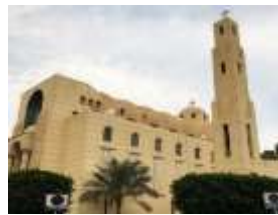
(شكل5) لقطة منظورية لمبنى الكنيسة من الخارج و تظهر التغطية بالقبو
